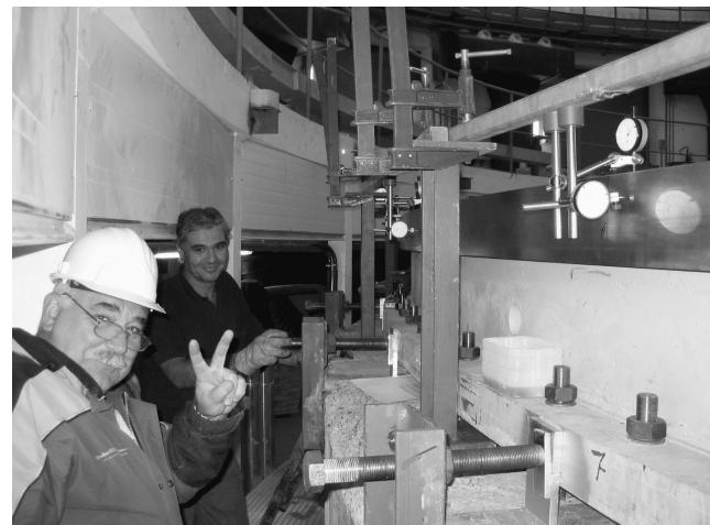
Fig. 1.: El jefe de montaje de la empresa contratista se muestra satisfecho ante la comprobación de la correcta alineación del anillo de acimut.
